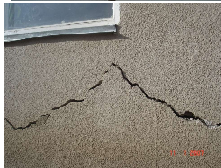
Повреждение школ в Кочкорском районе, кирпичная и глинистая кладка без усиления, во время Кочкорского землетрясения 2006, 2007, интенсивность 7 баллов
