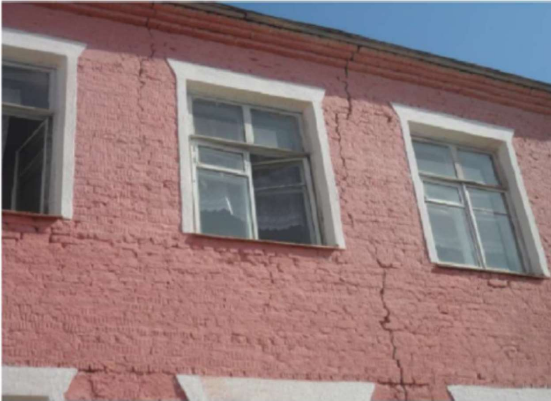
Повреждение школы им.Ленина в городе Ош, здание из кирпичной кладки без усиления после Карасуйского землетрясения 2008 года
