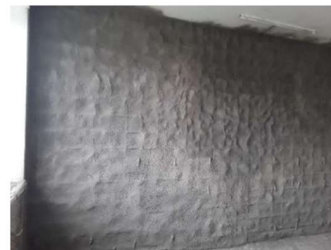
Армированная поверхность стены покрыта торкретированием (обрызгиваемый бетон) в 2 слоя (на фотографиях - после 1-слоя)
