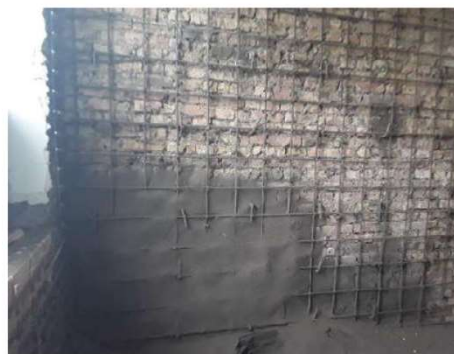
Армированная поверхность стены покрыта торкретированием (обрызгиваемый бетон) в 2 слоя (на фотографиях - после 1-слоя)
