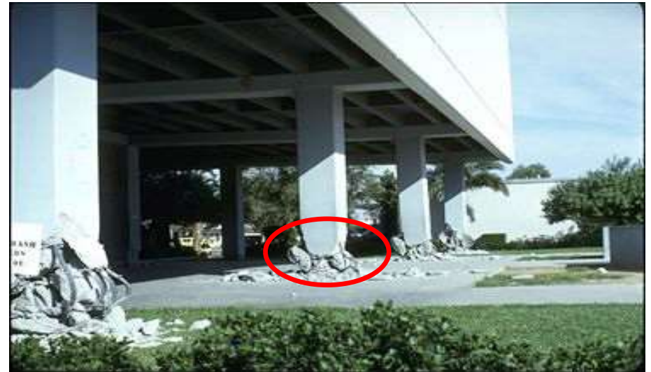
Пластические шарниры в ж/б колоннах
