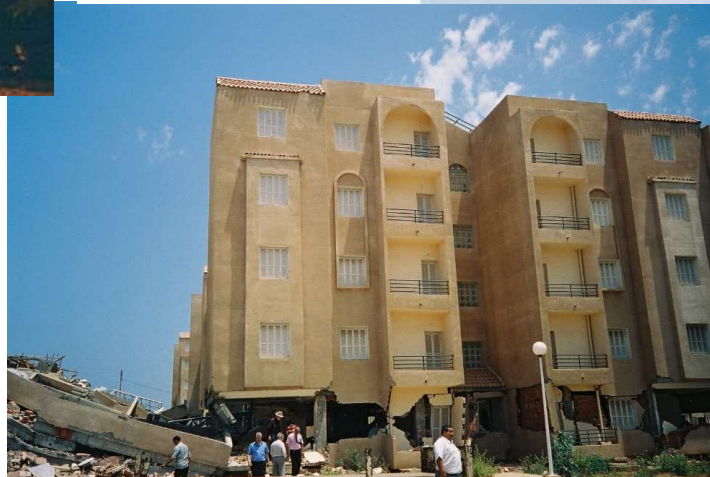
Землетрясение в г. Бумердесе, Алжир, 2003 г.
