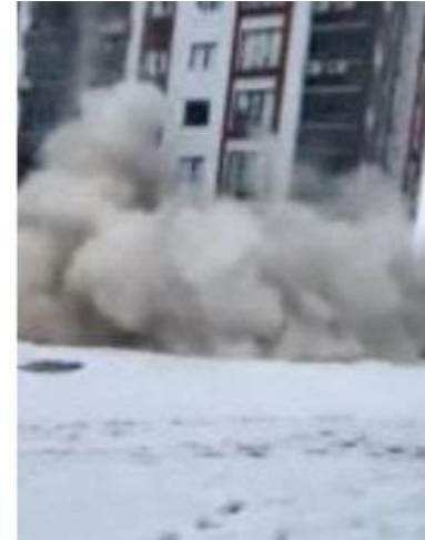
Землетрясение в Турции, 2023 г.
